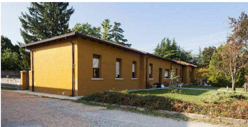
La struttura portante è costituita da muratura in laterizio negli ampliamenti successivi. I solai sono in laterocemento, mentre la copertura è realizzata con travi di colmo e secondarie in legno. Il manto è realizzato in coppi tradizionali. I corpi scala interni sono in calcestruzzo armato.
