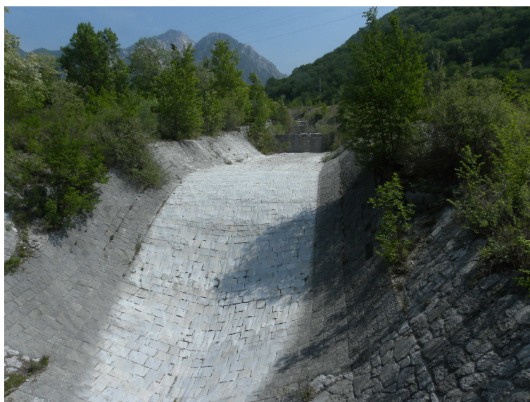
Importante regimazione delle sponde e del fondale nella parte terminale di Rio Grassignis
